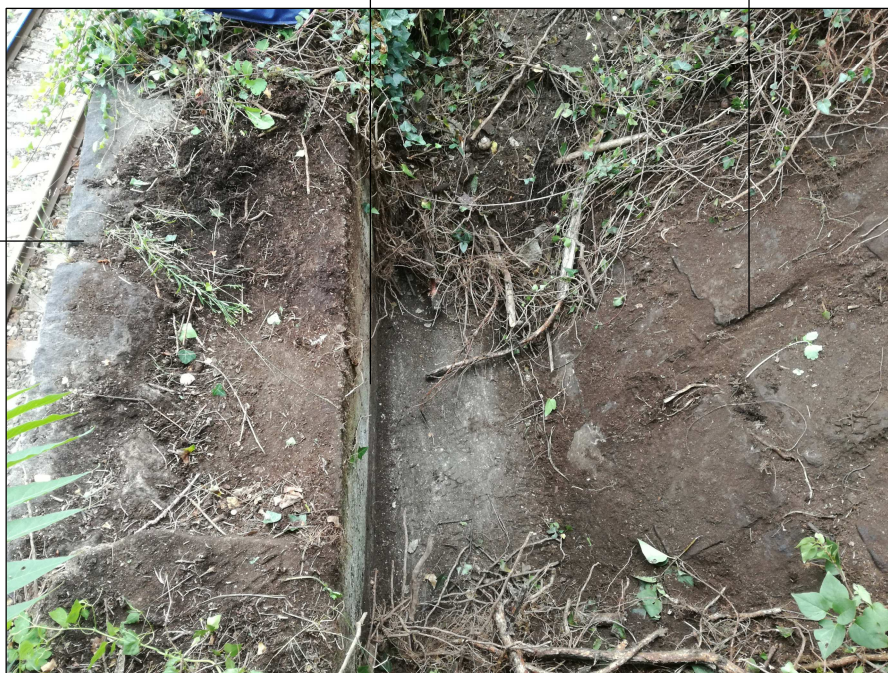
Obr. č.1: Kopaná sonda pro ověření tvaru zárubní zdi.
